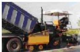
Macchina per la posa dell'asfalto utilizzata per la formazione del manto stradale
